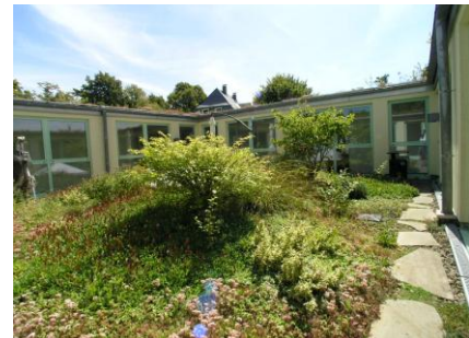
Innenhof im Neubau
