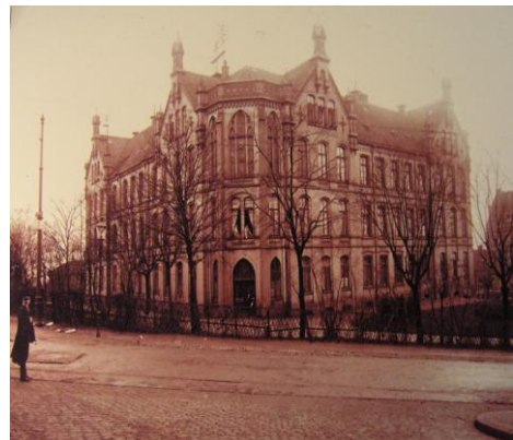
Altes Krankenhaus um 1910 Brüderstraße/Alleestraße
